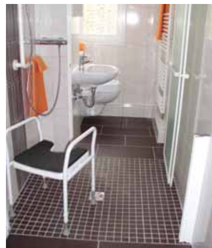
typische Pumpeninstallation im Schlauchbad
